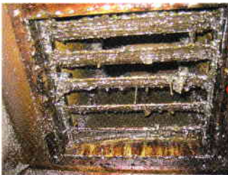
防火シャッター
